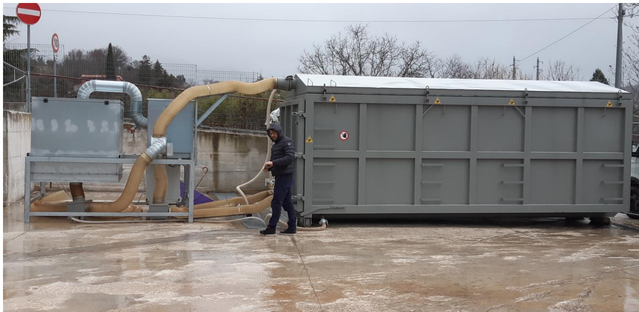
Modulo: biocella - gruppo ventilazione - biofiltro
